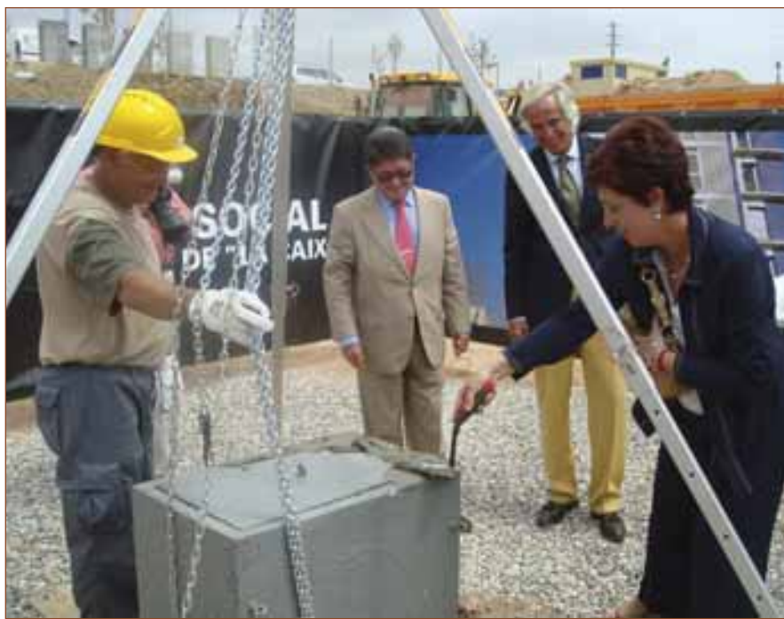
Moment de l'acte de col·locació de la primera pedra, amb la presència de l'alcalde de Salou, Antoni Banyeres, i la delegada general de "la Caixa" a Tarragona, Empar Martínez.
